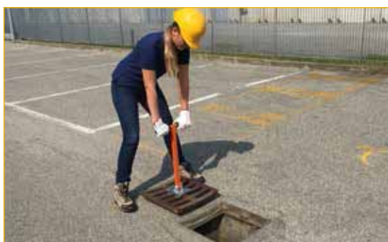
Sollevamento manuale di coperchi metallici medio/leggeri.
