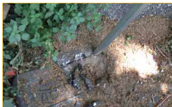
Utile per tagliare strati di asfalto e cemento, pulire e scrostare lo sporco, che spesso ricoprono la superficie e la giuntura del coperchio e permetterne l'apertura.
