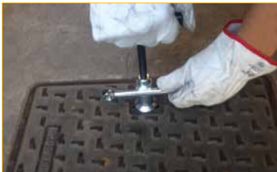
Fase 1: fissaggio della barretta centrale nella posizione favorevole alla leva.
