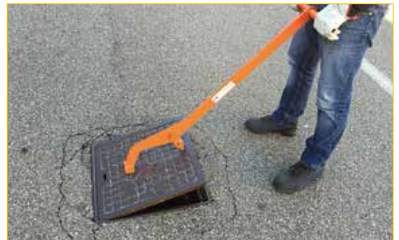
Nell'operazione di sollevamento la lunghezza della leva limita lo sforzo dell'operatore.
