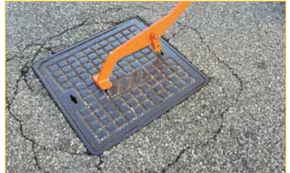
Inserimento del dente nell'asola e rotazione di 90°.
