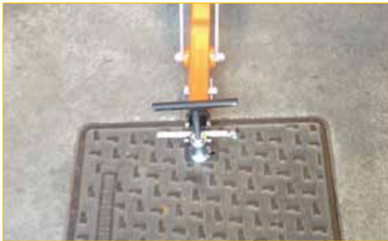
Fase 2: ingaggio della leva nel morsetto.
