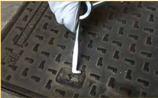
Configurazione 2 Estremità ad "L" per raschiare nel sotto squadra delle asole e liberare la rotazione delle chiavarde.
