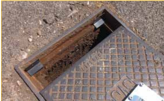
Posizionamento degli spessori tra coperchio e cornice.
